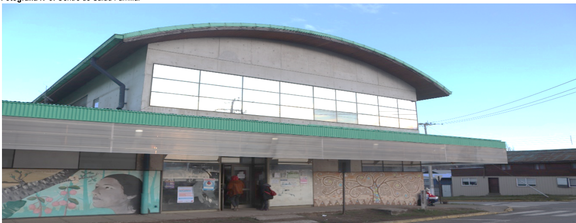
Fotografía N°9: Centro de Salud Familiar
